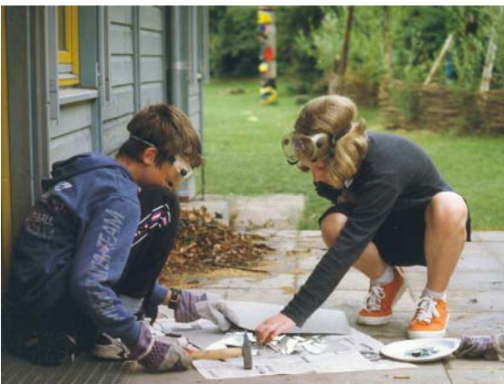
Die Fliesen werden zerschlagen
